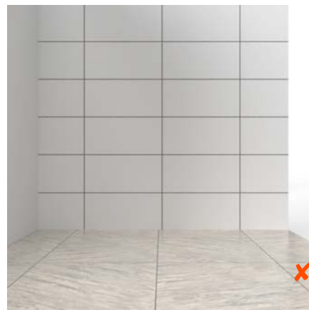
FIGUR 10 C. Fogar på golv och vägg avviker EJ markant.
