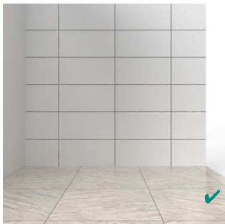
FIGUR 10 A. Fogar på golv och vägg avviker markant.
